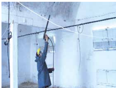
Opération de décapage du toit
