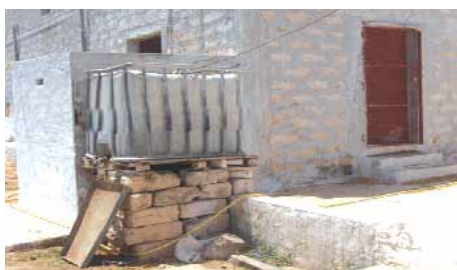
Bac d'eau en dehors du bâtiment
