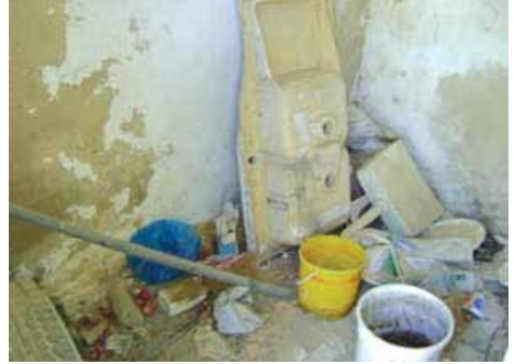
Débarras à l'intérieur du bâtiment !!
